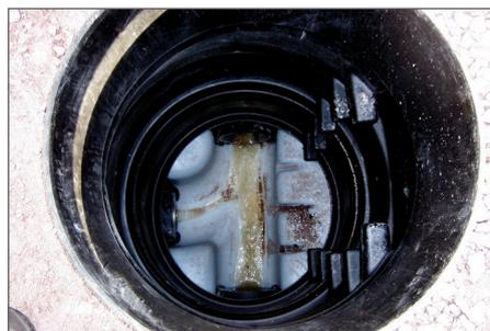
8. Fertig sanierter Schacht inkl. lastentkoppelter Abdeckung.
