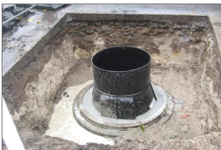
7. Verfüllen des Zwischenraums zwischen PE-Schacht DN 800 und Betonschacht DN 1000 mit Verfüllmörtel.
