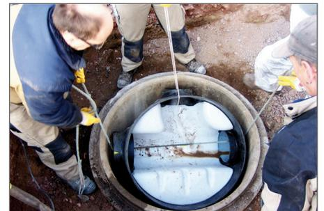
3. Vorgefertigtes Gerinne mit PE-Stützen anpassen und in Schachtboden einbringen.
