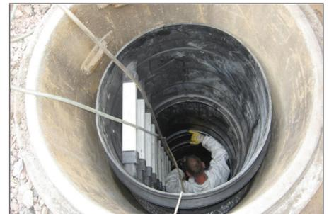
6. Aufsetzen der Dichtungen und Schachtbauteile – PE Schachtsystem DN 800.
