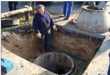
1. Asphalt aufschneiden, Betonkonus abheben.
