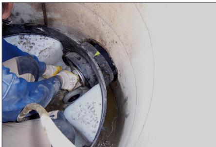
4. Absperrblasen an Ablauf und Zuläufen setzen, Verfüllen des Zwischenraums mit modifiziertem Verfüllmörtel.
