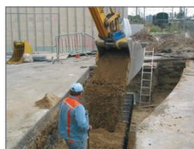
überdecken. Dadurch wird der Kabelkanal vor größeren Gegenständen, die in der Endverschüttung enthalten sein können, geschützt.
