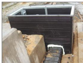
Säge im Schachtinneren abgelängt. Der entstandene Freiraum wird mit Schäummittel (z.B. PU-Schaum) verschlossen.
